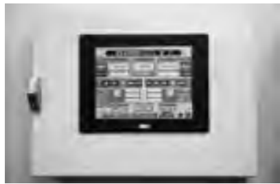
● 換気自動制御システム「NOAH Evolt」 室内や設備にセンサーを配置し、ホール内の空気環境を監視。無線のためセンサー類の追加や位置変更が容易。相反する空気環境保全と電気料金削減を実現する
