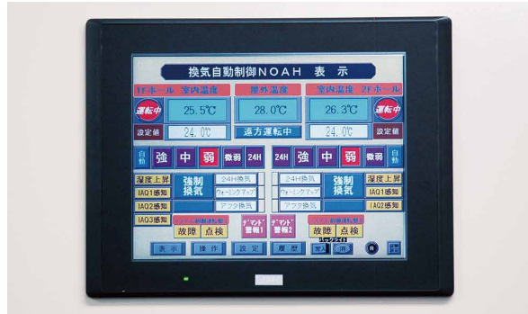
換気自動制御システム「NOAH」は、室内や設備に配置されたセンサーでホール内の空気環境を監視。換気風量などを制御し空気環境保全と省エネを実現する。2019年には電気料金削減を主眼においた「NOAH EVOIL」として再リリースした。
